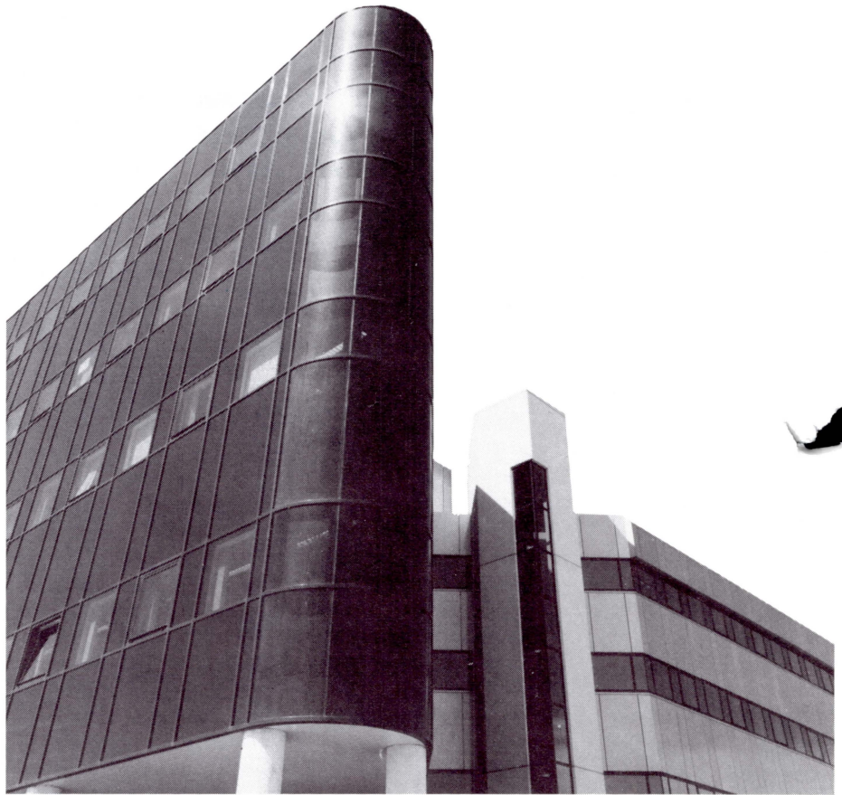
Het moderne gebouw van Fisher Controls
